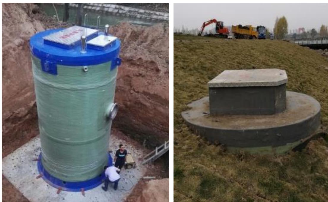
图 4.1-2 一体化式泵站照片
